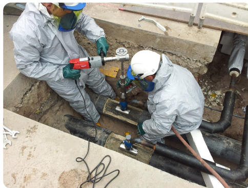
Anbohrung im laufenden Betrieb – auf der Baustelle
